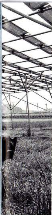
トラクターなど農業機械を支障なく運用できるよう、太陽光パネルは十分な高さ（最低2m以上）に設置される＝千葉エコ・エネルギー提供
