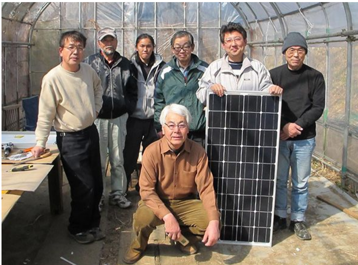
NPO 世界環境改善連合の仲間たちと、アルミレールの取り付け作業
